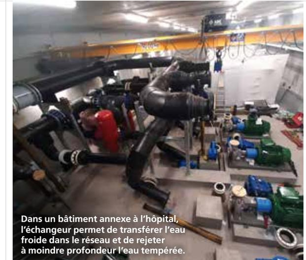
Dans un bâtiment annexe à l'hôpital, l'échangeur permet de transférer l'eau froide dans le réseau et de rejeter à moindre profondeur l'eau tempérée.
